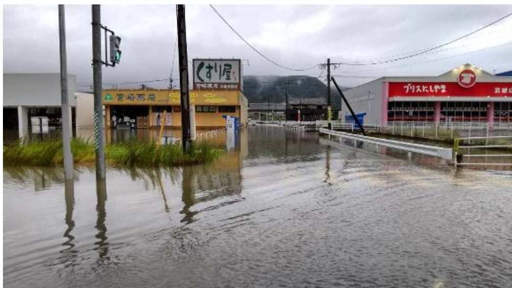
図11 冠水し通行止めとなった国道34号及び浸水店舗（佐賀県武雄市）
