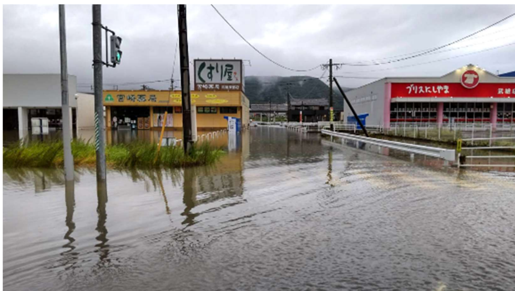
図11 冠水し通行止めとなった国道34号及び浸水店舗（佐賀県武雄市）
