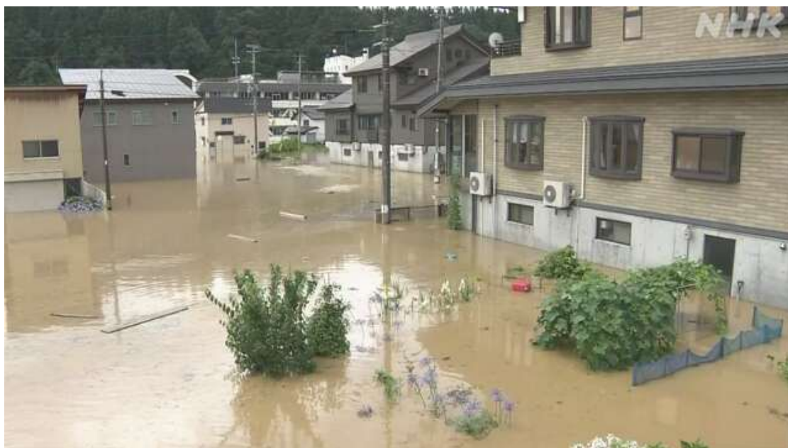
図15 山形県における浸水被害の状況 61
