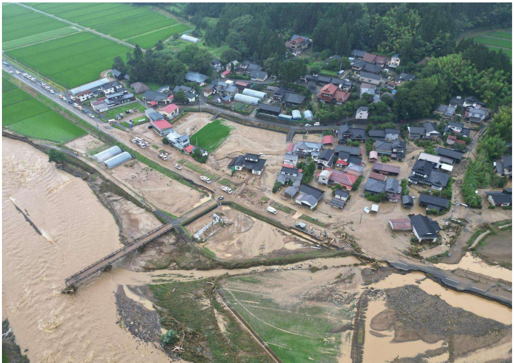
図14 荒瀬川の決壊により、浸水などの被害を受けた住宅 58
